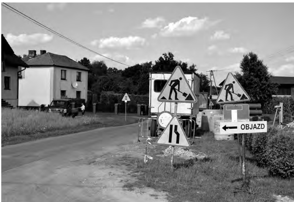
Trwa remont ul. Szkolnej w Suszcu. Na czas prac wyznaczono objazd
